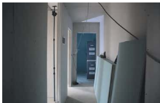
Jedno z remontowanych mieszkań w Piotrkowiczkach
