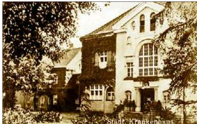
Budynek starego szpitala uwieczniany był na licznych przedwojennych widokówkach.
