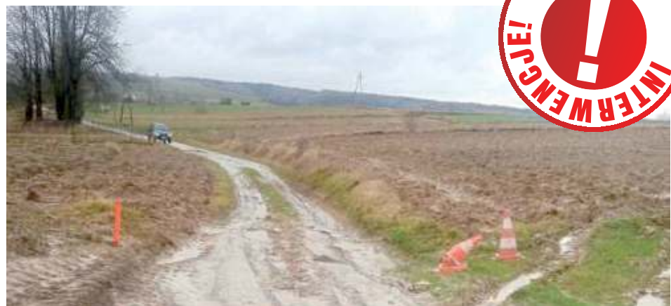
Grunt po prawej stronie od słupków geodezyjnych, zgodnie z pomiarem przeprowadzonym 14 grudnia przez geodetę, stanowi własność prywatną. Droga miejscami jest jednak utwardzona asfaltem, a ruch pojazdów trwa w najlepsze
