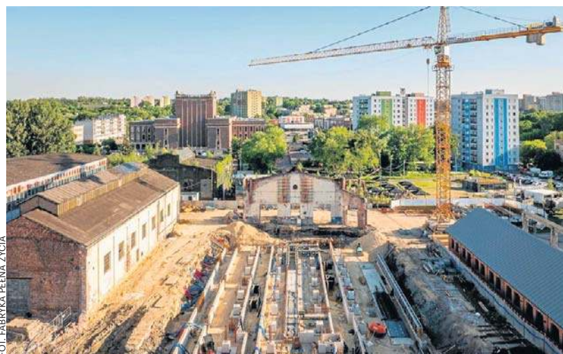
Pierwsza gotowa będzie Hala Tworzeń. Powstaje tu przestrzeń konferencyjno-targowo-koncertowa. Obok stanie Hala Ząbkowice
