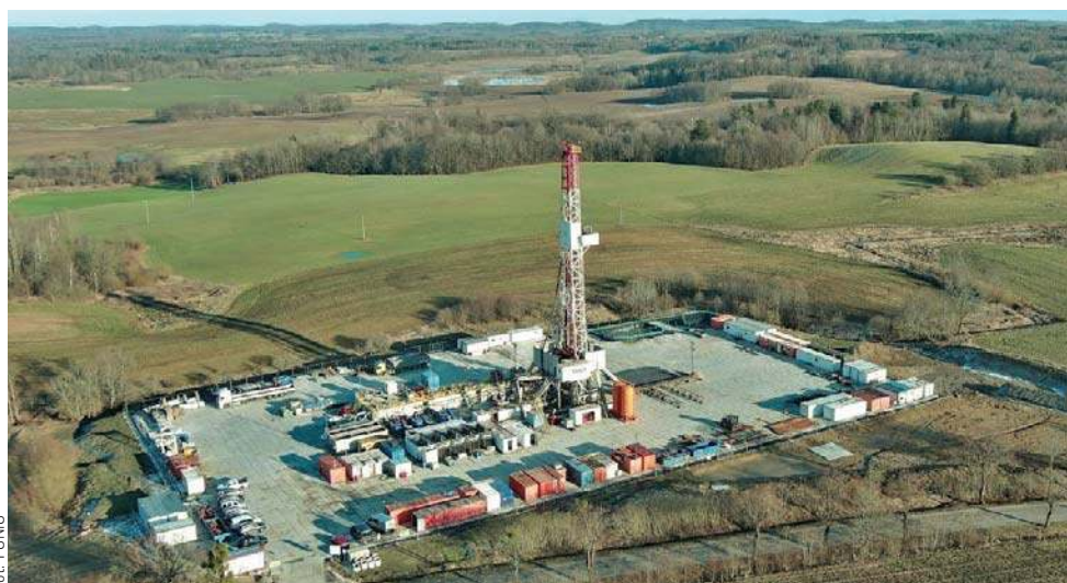
Odwiert Miłaki-1K na terenie zakładu górniczego w Głębocku. Zdjęcie z 28.02.2023 r.
