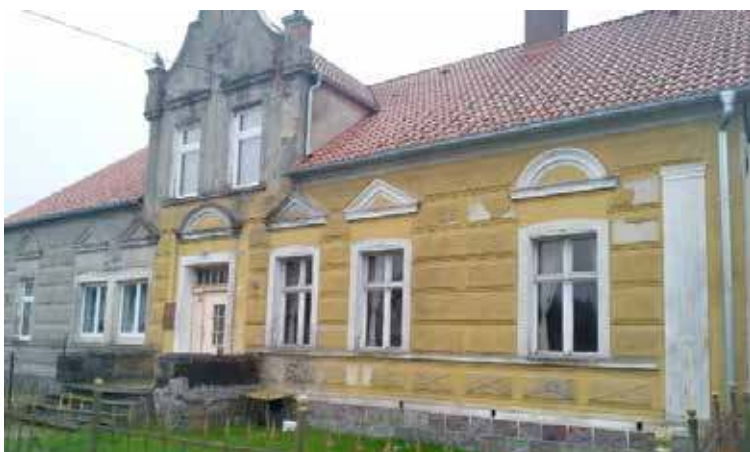
Świetlica wiejska w Glewicach zajmuje część pomieszczeń w jednym z budynków
