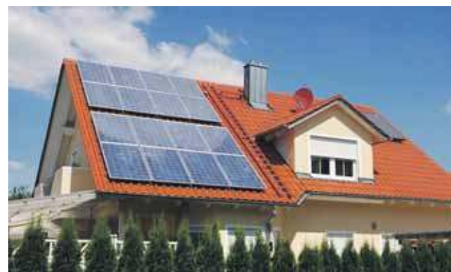
W ramach projektu mają powstać w sumie 673 instalacje fotowoltaiczne
