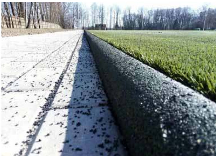
Na bocznym zamontowane zostały elastyczne gumowe nakładki na krawężniki zwiększające bezpieczeństwo piłkarzy
