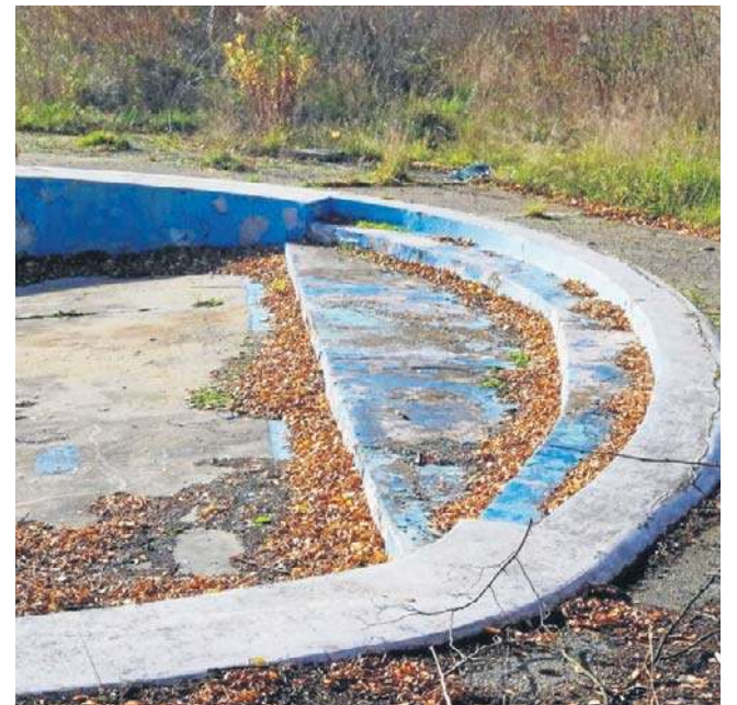
Niecki basenowe są spękane, nie nadają się do eksploatacji
