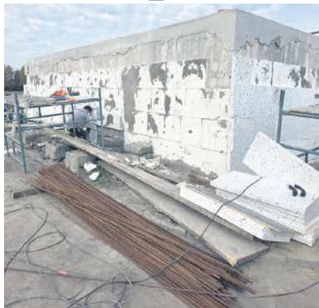
Modernizacja oczyszczalni w Jarczowie.
