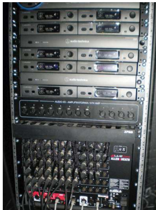
...oraz modułu miksującego CDM 48 z sekcją I/O, umieszczonego w szafie rackowej z tyłu sceny.
