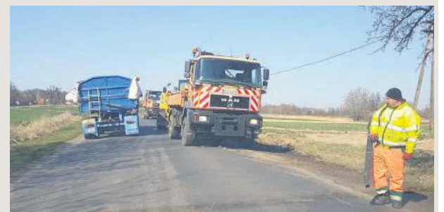
Na trasie Krzywina - Przeworno pod koniec marca ruszyła ścinka poboczy
