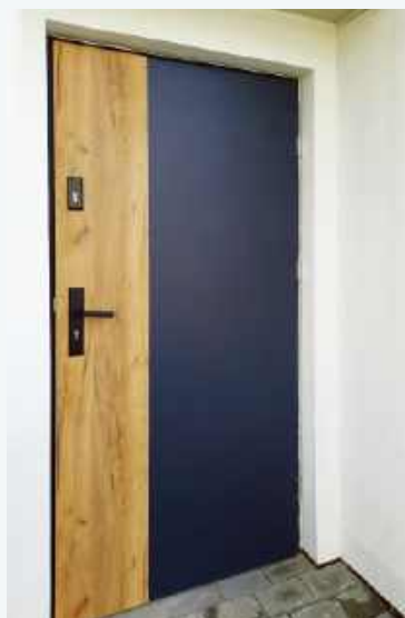
Przy ścianie niezbędne jest zamontowanie odbojnika.
