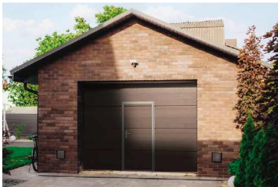
📌 Drzwi przejściowe w bramie garażowej mogą mieć niski lub wysoki próg. Zwiększają one funkcjonalność i wygodę użytkowania garażu, bo pozwalają korzystać z niego bez otwierania całej bramy. Ma to znaczenie zwłaszcza zimą, bo ogranicza straty ciepła. STALPRODUKT-ZAMOŚĆ
