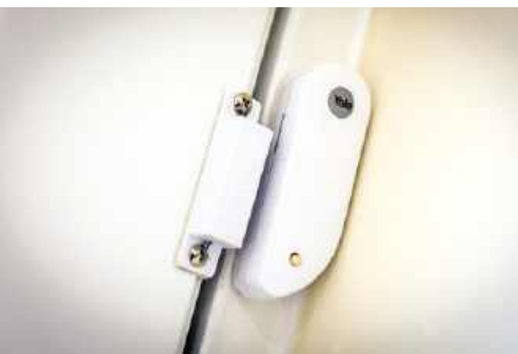
Ważnym elementem ochrony stolarki są kontaktrony, które wzbudzają alarm w momencie otwarcia okien i drzwi. YALE
