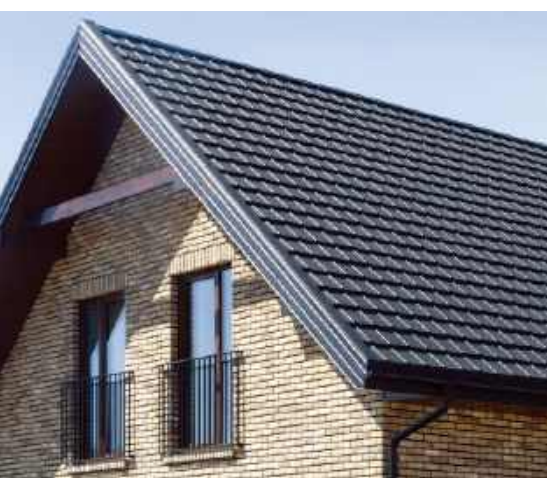
🔧 Przy prostych dachach do montażu blachodachówki zazwyczaj wystarczą dwie osoby, a prace przebiegają sprawnie. RUUKKI
