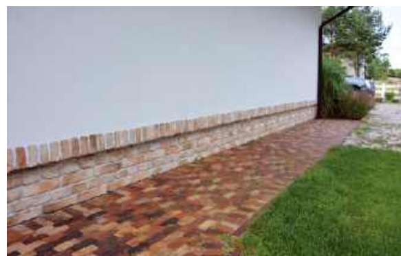
❸ Dolna część elewacji, czyli cokół budynku, jest najbardziej narażona na zabrudzenia i wilgoć. Dlatego często wykańcza się ją bardziej odpornymi materiałami, np. płytkami lub kamieniem. ELKAMINO DOM
