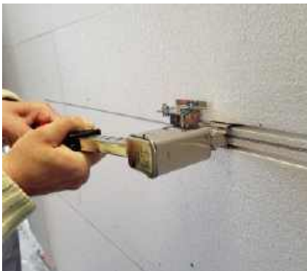
❶ Boniowanie polega na wykonywaniu płytkich zagłębień w warstwie tynku, które tworzą dekoracyjne podziały elewacji i podkreślają bryłę budynku. BELLA PLAST
