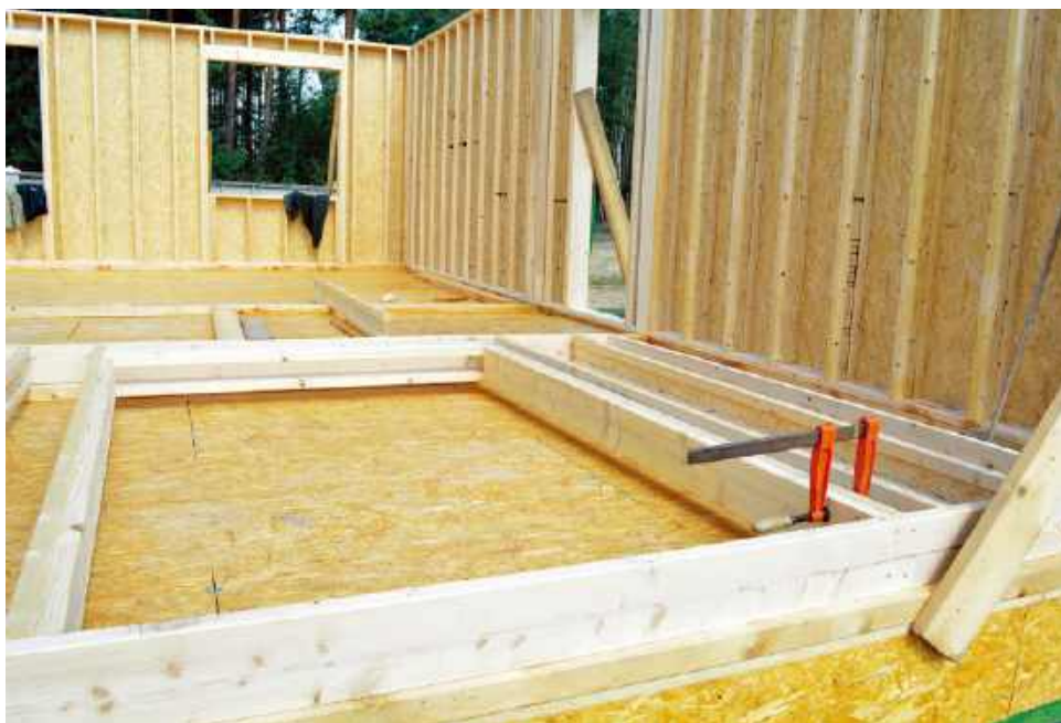
❶ Montaż ścian zewnętrznych i wewnętrznych stanowi bazę stabilnej konstrukcji, następnie wykonywana jest więźba z prefabrykowanych wiązarów dachowych oraz uszczelnienie całego budynku. KRONOPOL
