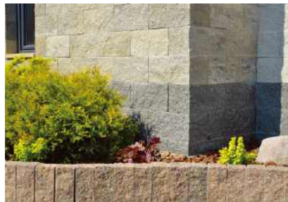
❷ Betonowe płytki elewacyjne dobrze komponują się z innymi elementami z tego samego materiału, np. obrzeżami rabat czy murkami ogrodowymi, tworząc spójną aranżację wokół domu. JONIEC
