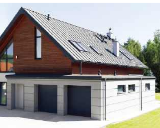
🔧 Dach pokryty blachodachówką jest z reguły tańszy od wykończonego dachówkami. RUUKKI
