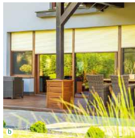
📍 Roleta natynkowa w kasecie, montowana na elewacji gotowego okna, widoczna z zewnątrz (a SOMFY). Roleta podtynkowa, ukryta w ścianie nad oknem; montuje się ją na etapie wznoszenia ścian i tynku (b KRISHOME).
