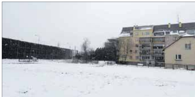
Przepompownia przy ulicy Cegielnianej w Jaworznie
