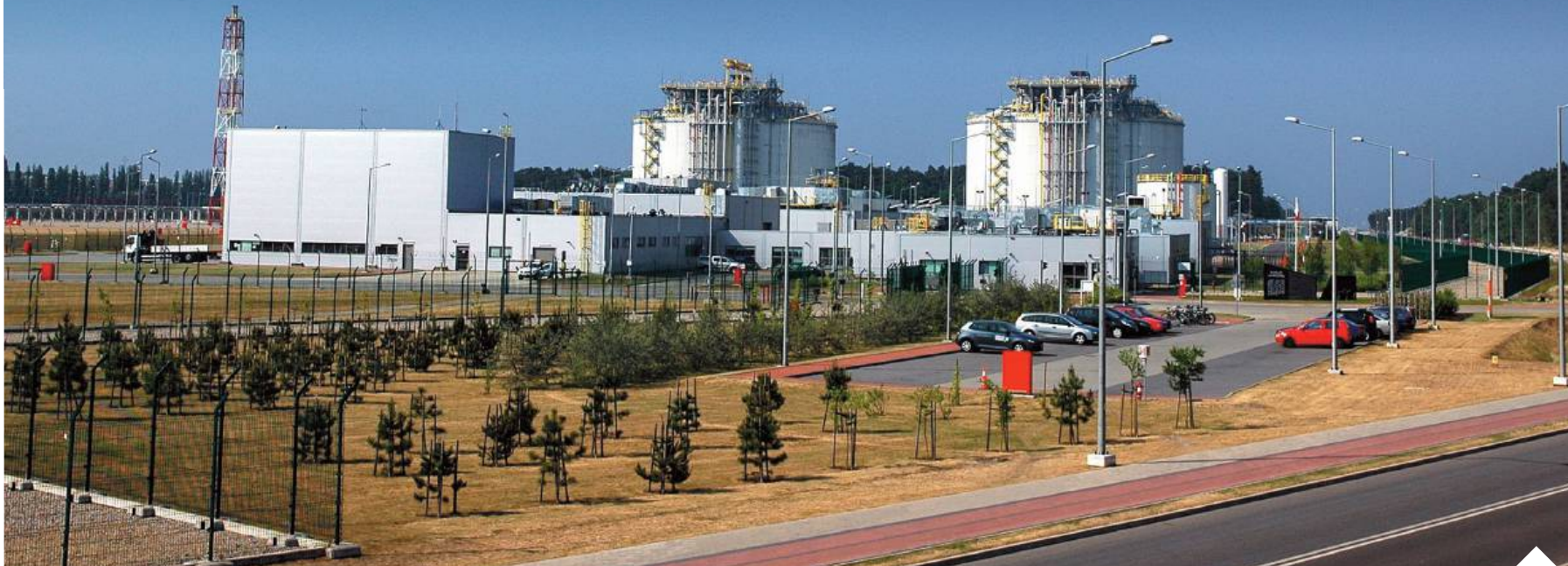
Dzięki trzeciemu zbiornikowi LNG w terminalu w Świnoujściu Polska zwiększy swój potencjał w zakresie skroplonego gazu ziemnego | fot. Wikipedia/d
