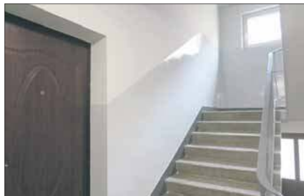
Świeżo odmalowane klatki schodowe prezentują się bardzo estetycznie
