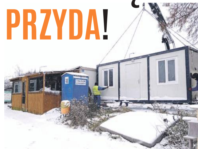
Do ustawienia kontenera wykorzystano dźwig
