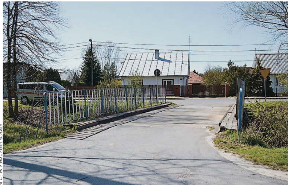
Samorząd Rudnika nad Sanem otrzymał wsparcie z Funduszu Dróg Samorządowych na remont mostu na Rudnej w ciągu ulicy Głowackiego
