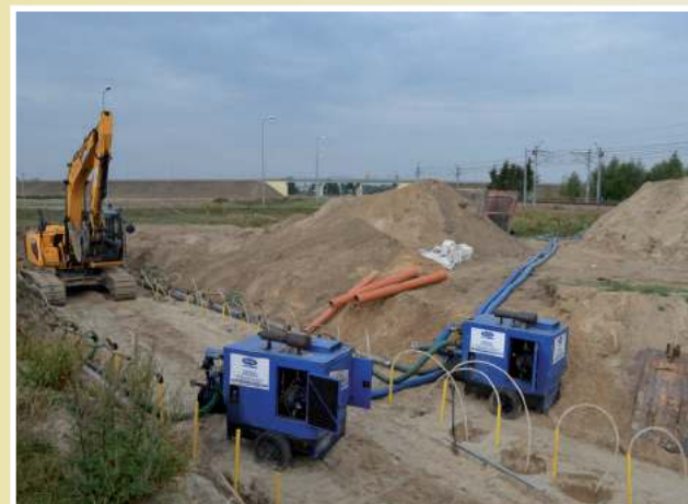
W Gminie Międzyrzec powstanie 20 km sieci kanalizacji sanitarnej, która posłuży mieszkańcom Rzeczy
