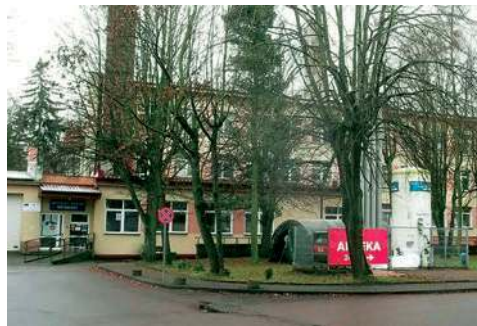
Na unowocześnienie obiektu mławskiego szpitala, a także na doposażenie go w specjalistyczny sprzęt, w ostatnich latach poszło wiele milionów złotych, w tym z budżetu samorządu powiatowego
