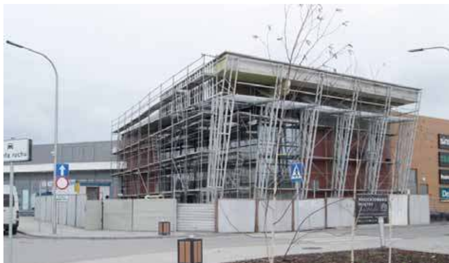
Dworzec zintegrowany w budowie
