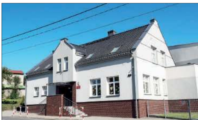
■ Obecnie w przebudowanym budynku szkoły mieści się Zespół Szkolno-Przedszkolny im. Janusza Korczaka
