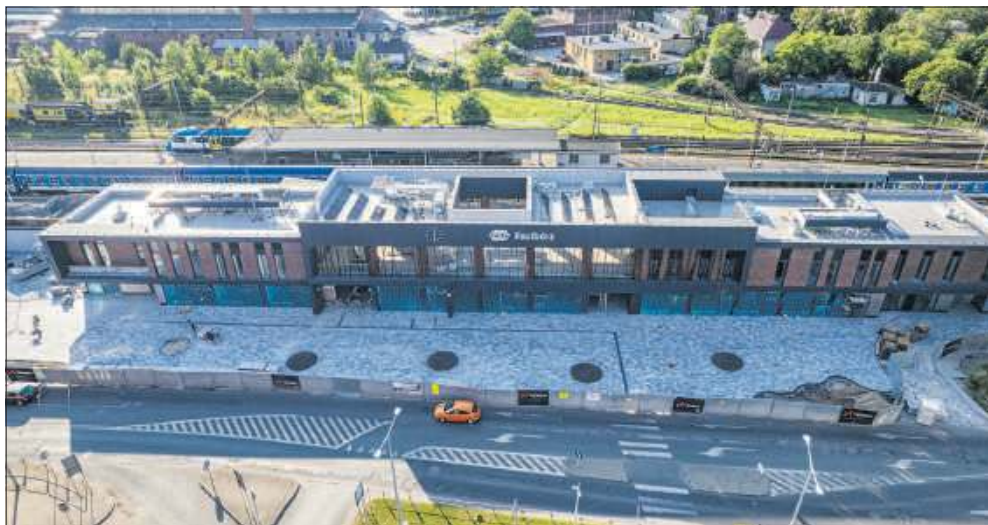
■ Widok wyremontowanego dworca z lotu drona
