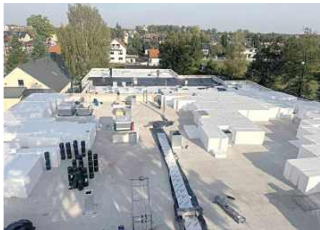
Budowa żłobka i przedszkola w Garwolinie znów nabiera tempa. Widać już dużą zmianę
