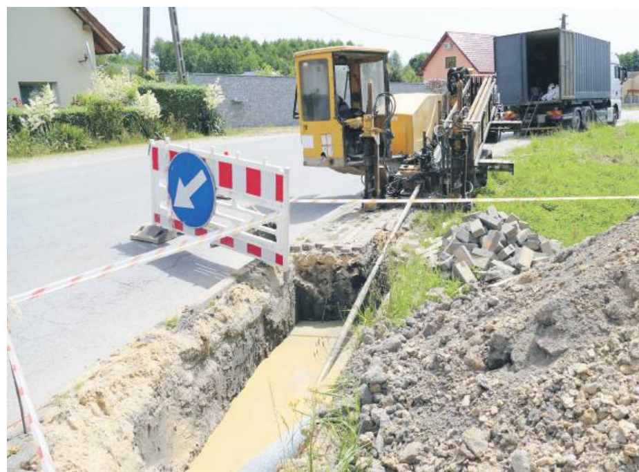
Do budowy nowej sieci wodociągowej firma wykorzystuje specjalną maszynę, która wierci pod ziemią otwory i wprowadza w nie rury
