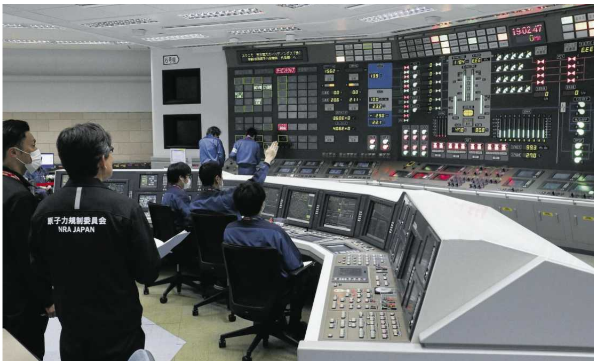
• Japońska elektrownia jądrowa Kashiwazaki-Kariwa FOT. KYODO/VIA REUTERS
