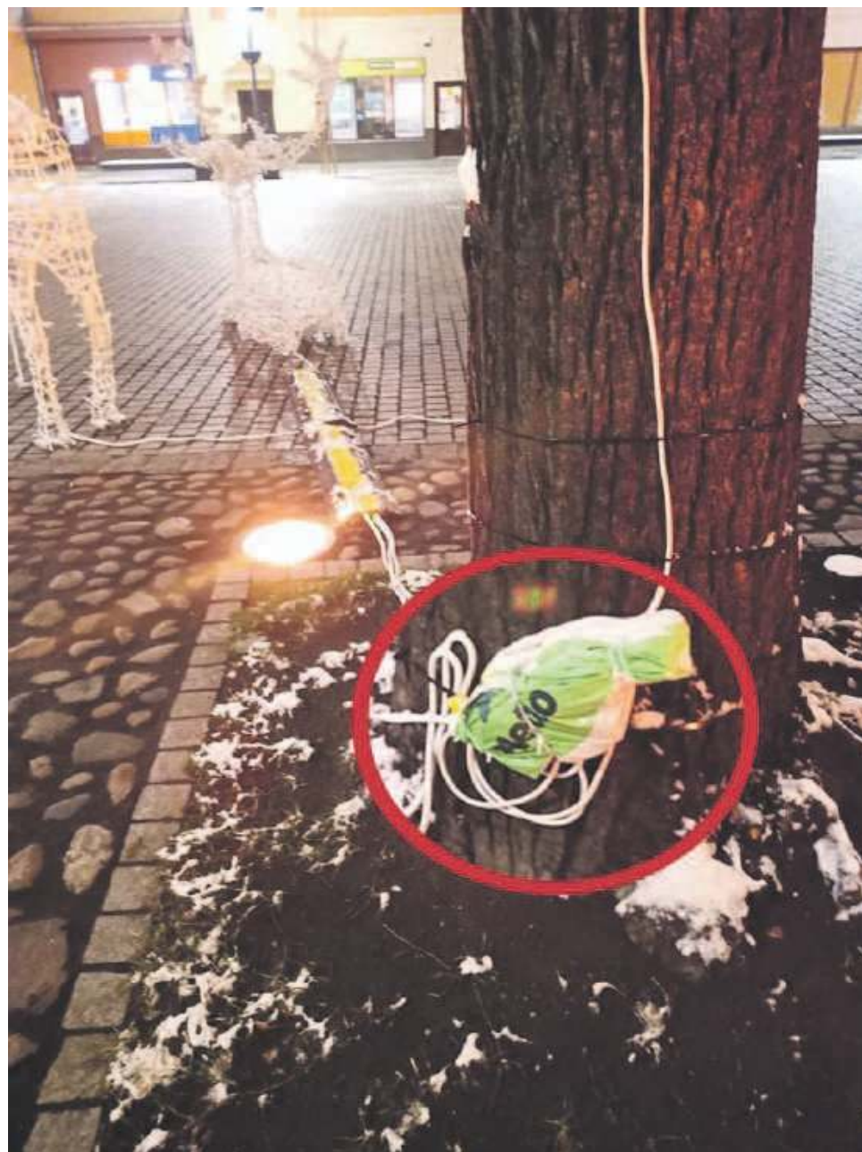
Przedłużacz zawinięty w reklamówkę. To było tymczasowe rozwiązanie. Mieszkaniec, który to zgłosił redakcji, wskazał na poważne zagrożenie
