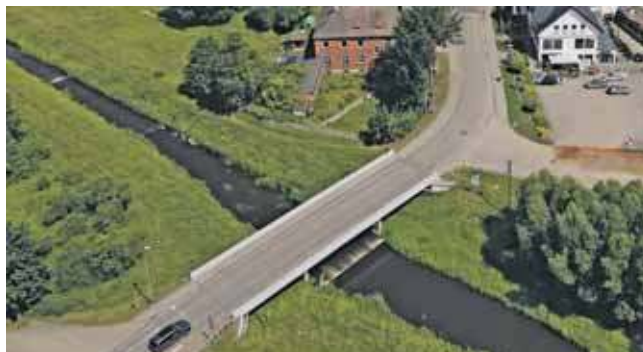
Dla układu komunikacyjnego Kalet most na ul. ks. Drozdka ma fundamentalne znaczenie. Jest podstawowym połączeniem centrum z dzielnicą Jędrysek
