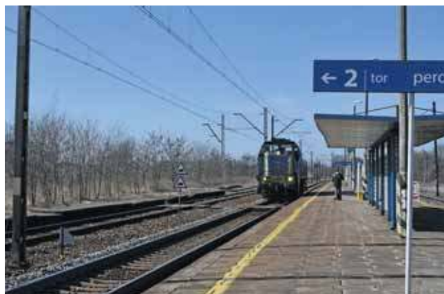
W Nakle Śląskim ma powstać podziemne dojście do peronów i na drugą stronę torów
