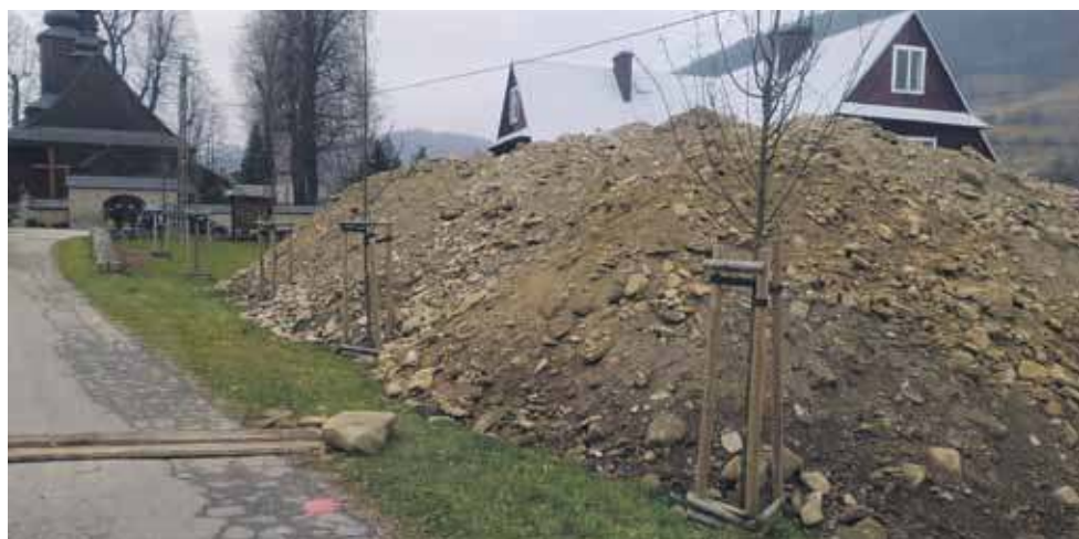
Drzewka zasypane ziemią z wykopów.
