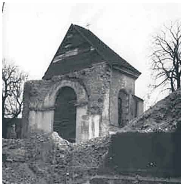
Rozbórka starego kościoła (MMJ)
