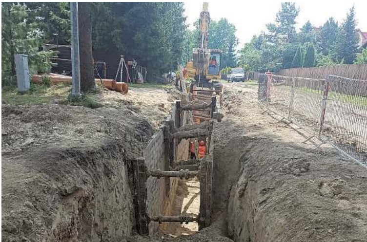
Prace drogowe i przy budowie głównego kolektora sieci kanalizacyjnej na ul. Wiercieńskiego idą pełną parą. Mieszkańcy mają niewiele czasu, by zdecydować się na przyłączenie do sieci
