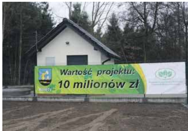
Stacja podciśnieniowa, obsługująca Miotek jest w stanie przyjąć także ścieki z sąsiednich dzielnic. To wpływa na koszty budowy kanalizacji w Zielonej
