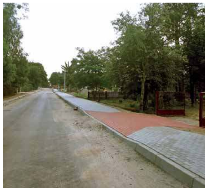
Droga w Mącicach będzie bezpieczniejsza
