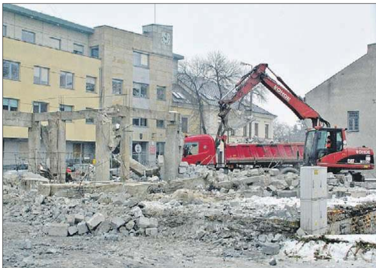
W sobotę 27 stycznia rozpoczęła się rozbiórka niedokończonego budynku przy ul. Piłsudskiego. Rudera przestanie straszyć, a w tym miejscu będzie parking na 60 miejsc
