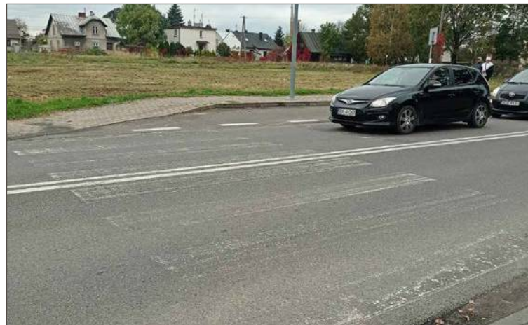
Zebra na Kościuszki, choć sfrezowana, to jednak wciąż widoczna.
