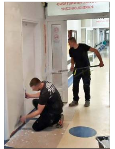
Trwają ostatnie prace remontowe.
