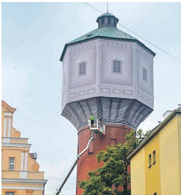
Pół roku czekał inwestor na zgodę konserwatora zabytków, aby taką siatkę zabezpieczającą zainstalować
