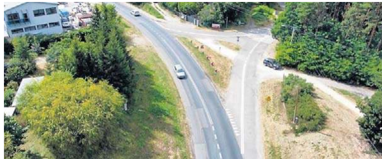
Od wiosny trwa przebudowa drogi wojewódzkiej 551 pomiędzy Strzyżawą i Ostromeckiem oraz Ostromeckiem i Nowy Dworem
