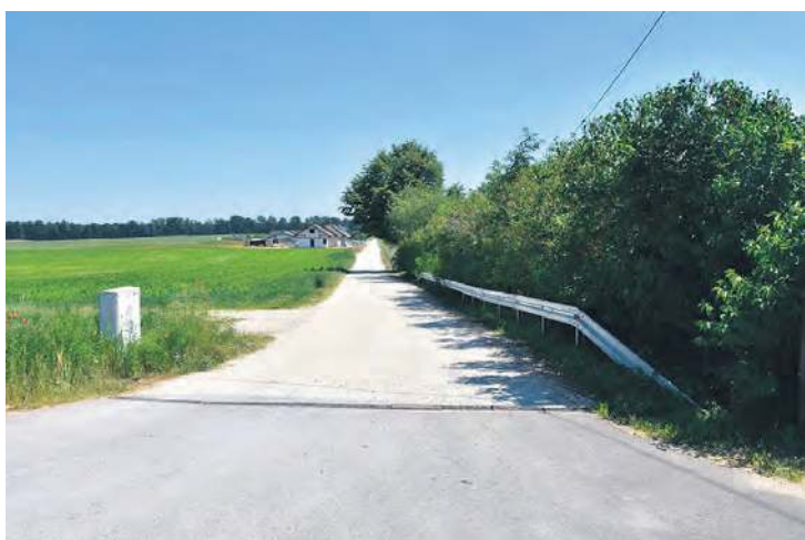
Droga w Łyskowie w kierunku Świt zostanie wykonana w nawierzchni asfaltowej.
