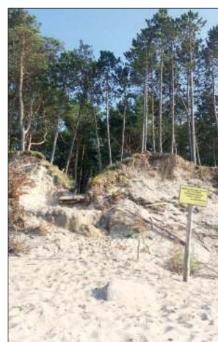
Plaża w Pleśnej przed rokiem, charakterystyczne wejście, zniszczone przez sztorm
