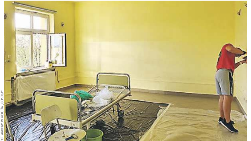
Kibice nizańskiego „Sokoła” remontują sale miejscowego szpitala
