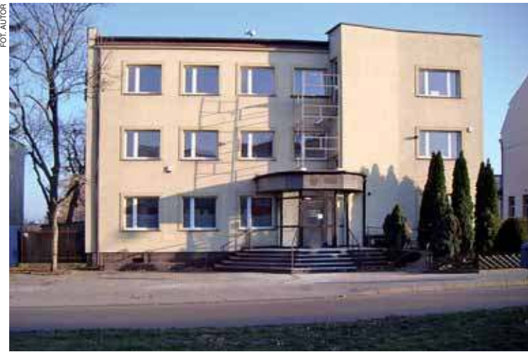
Nowa siedziba Biura Powiatowego ARiMR w Mławie
