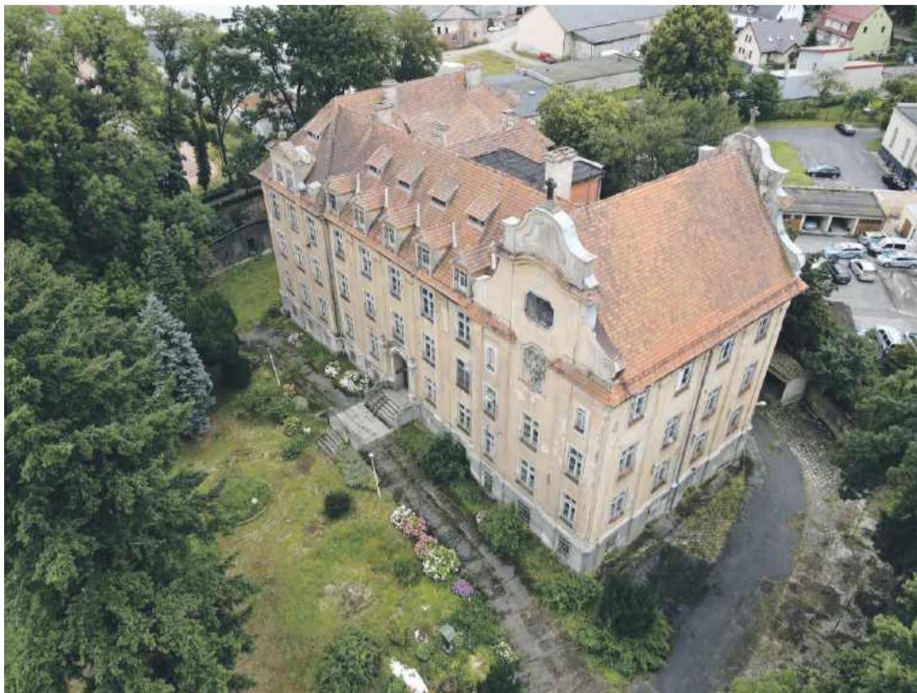
Gmina w 2021 roku, korzystając z prawa pierwokupu, za blisko 8 mln zł kupiła od sióstr Boromeuszek stary budynek. Od 4 lat stoi i niszczeje. Został nawet splądrowany
