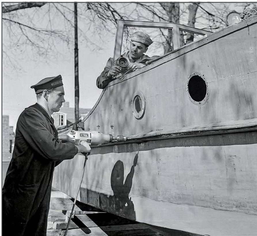
Zdjęcie wykonane w kwietniu 1952 r. Remont jednostki pływającej, której linie kadłuba przypominają niemieckie motorówki pokładowe typu V.
