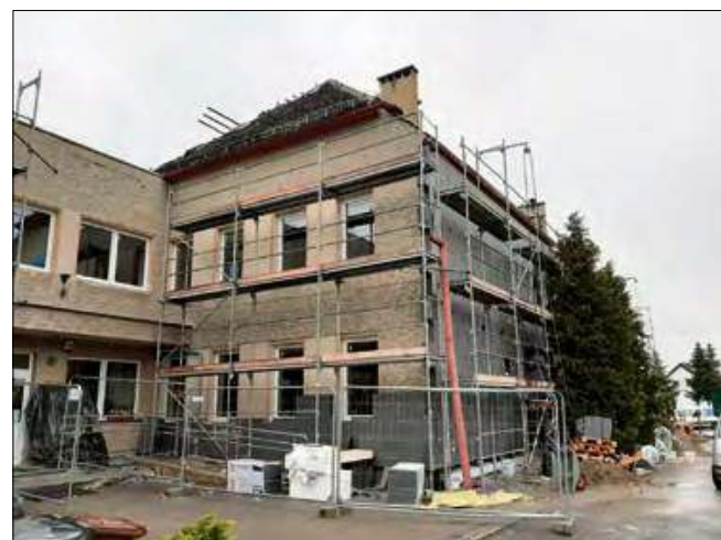
Prace termomodernizacyjne przy budynku szkolno-przedszkolnym w Komornikach idą pełną parą.
