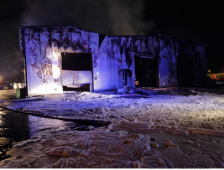
Fot. KPP Straży Pożarnej w Wołowie
