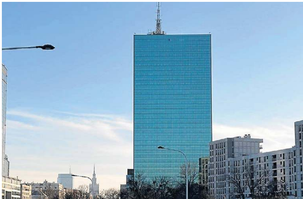
Budowa Intraco zaczęła się w 1973 r., skończyła dwa lata później. W latach 90. zmieniono mu elewację. Teraz zostanie zburzony. Nowe Intraco ma być gotowe w 2030 r.
