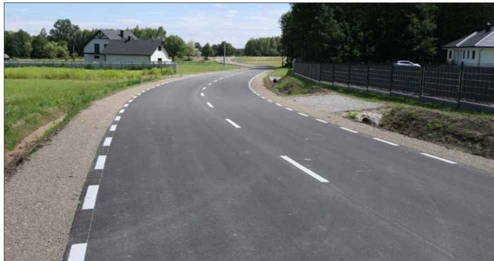
Jedna z ostatnich inwestycji powiatowych: nowa nawierzchnia, pobocza, odwodnienie i pełna infrastruktura techniczna sprawiły, że dawna droga gruntowa w Kłapówce zyskała standard nowoczesnej trasy klasy Z.
