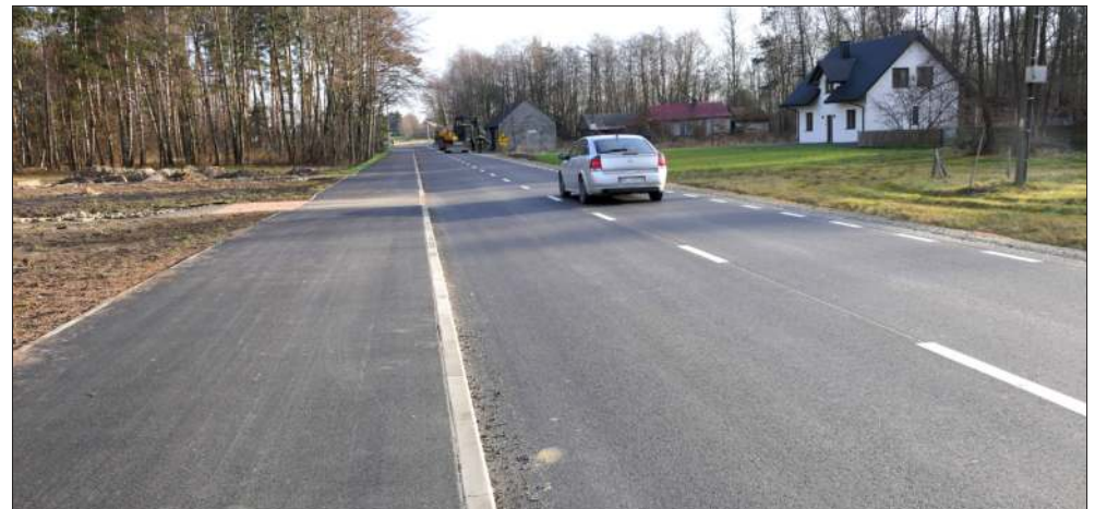
I kolejna udana inwestycja drogowa, tym razem w Kupnie, która obejmowała: poszerzenie jezdni do 6 metrów, budowę ścieżki pieszko-rowerowej o szerokości 3 metrów na prawie 3-kilometrowym odcinku, modernizację odwodnienia, wykonanie poboczy, zjazdów oraz nowego oznakowania pionowego i poziomego, które zwiększa czytelność i bezpieczeństwo ruchu.
