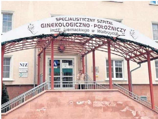
Szpital Ginekologiczno-Położniczy przejdzie termomodernizację. Zdobył na to 5,6 mln zł dofinansowania z UE.
