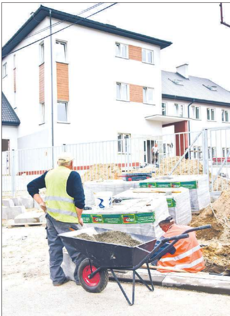
Wokół budynku układana jest już kostka. ŚDS ruszy za kilka miesięcy.
