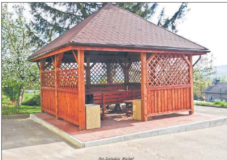
Altana rekreacyjna przy Domu Ludowym w Bukowej jest już gotowa.
