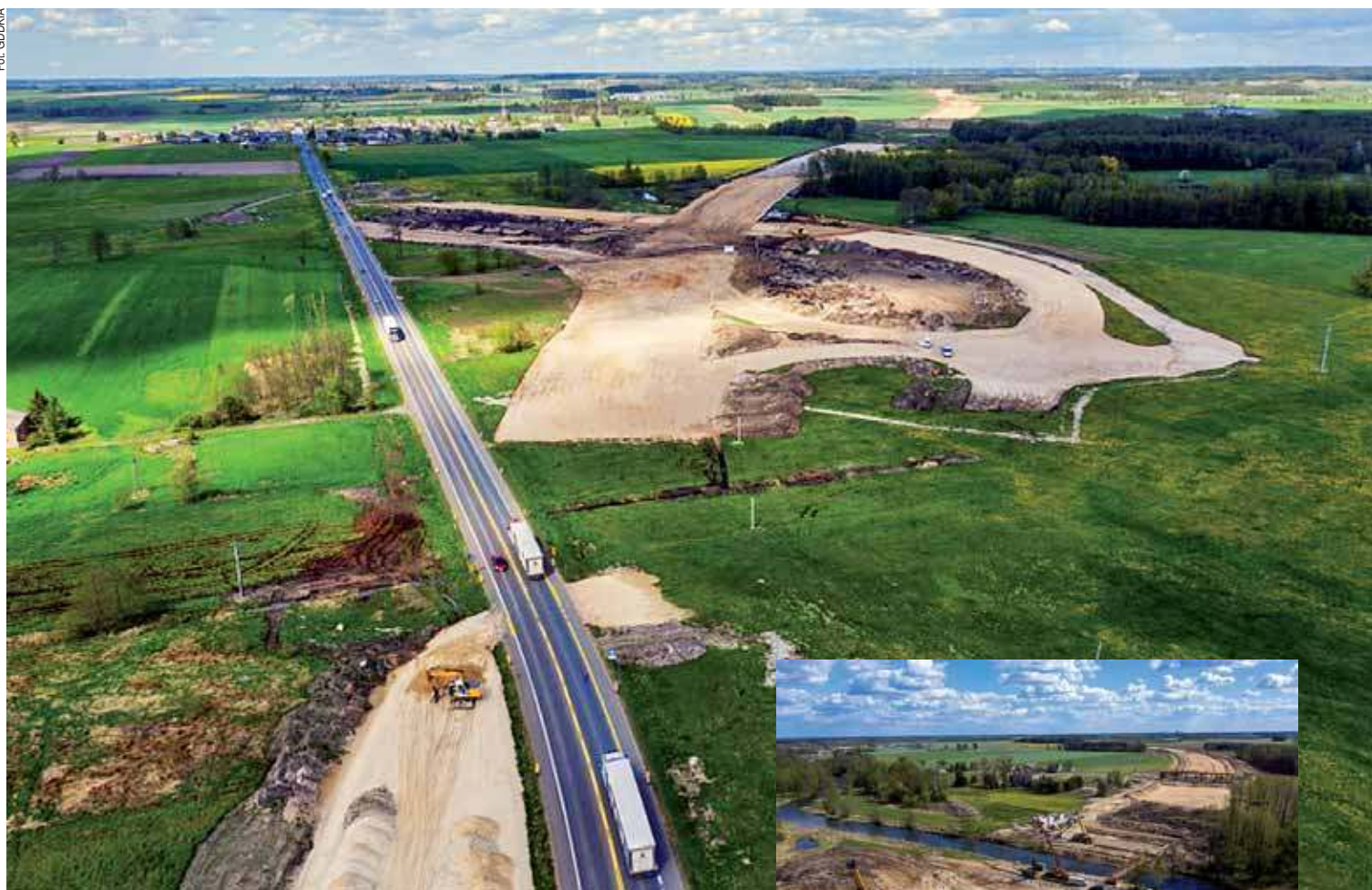
Inwestycja jest podzielona na cztery odcinki realizacyjne
