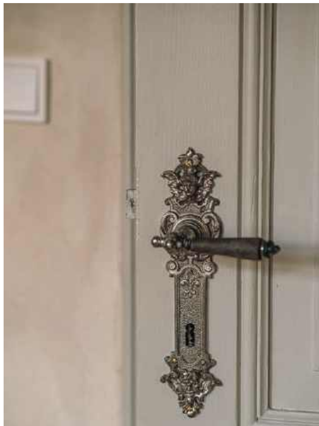
KLAMKI, drzwi i ościeżnice oczyszczono z wielu warstw farby, natomiast liczne ślady uszkodzeń pozostały i wpisały się w nieidealny charakter wnętrza.
